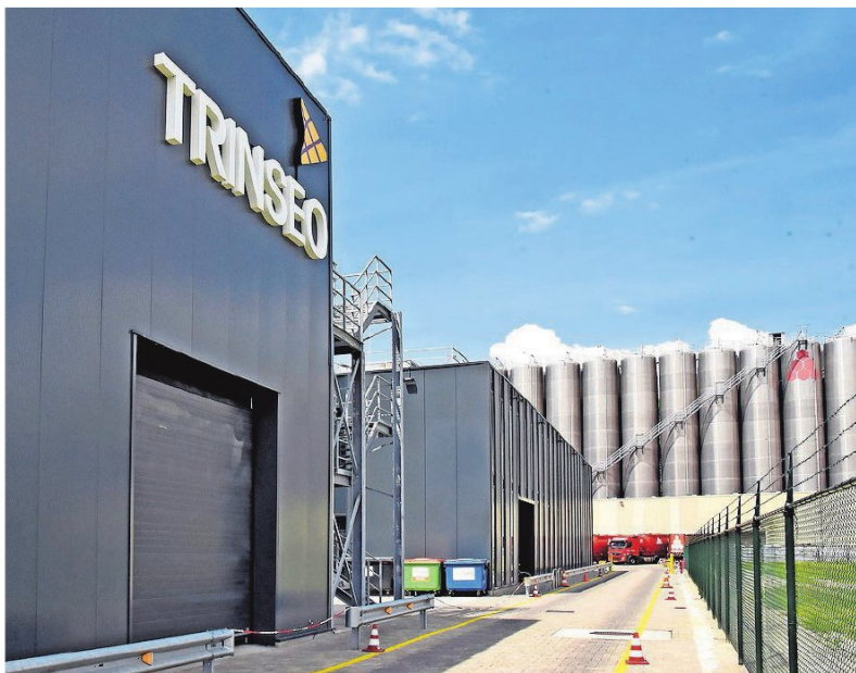
▲ De styreenfabriek van Trinseo in Terneuzen, waar 450 mensen werkten, sloot op 1 november de deuren. ARCHIEFFOTO PETER NICOLAI
